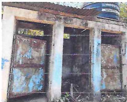
Cambio de puerta de sanitario
