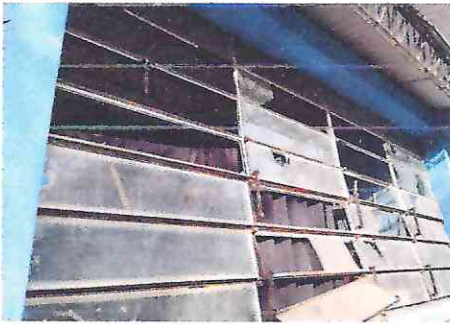
Sustitución de estructura de ventanas
