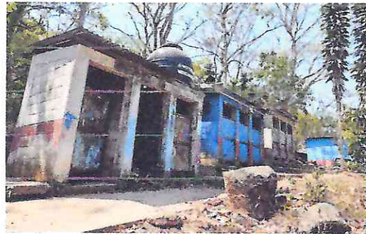
Pintura de sanitarios
